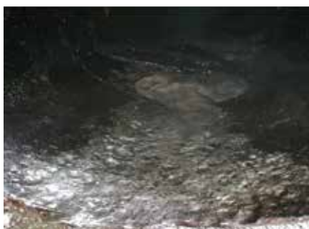
Hình 4. Bên trong đoạn nằm ngang trên MSP-11 của đường ống MSP-11 → MSP-9.
